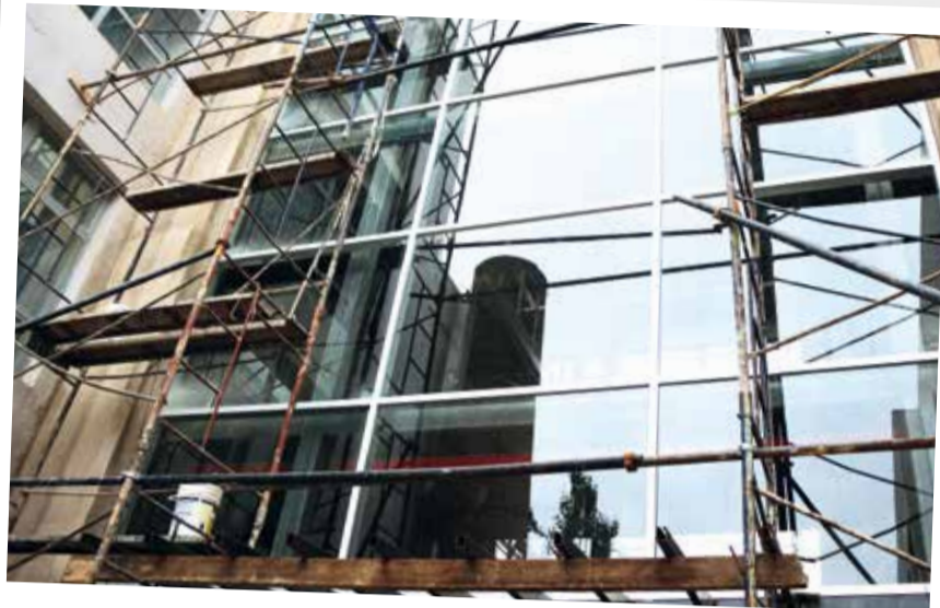
Infraestructura. Avanzan las nuevas obras en la Sede Piñeyro para aportar al bienestar de toda la comunidad universitaria.
